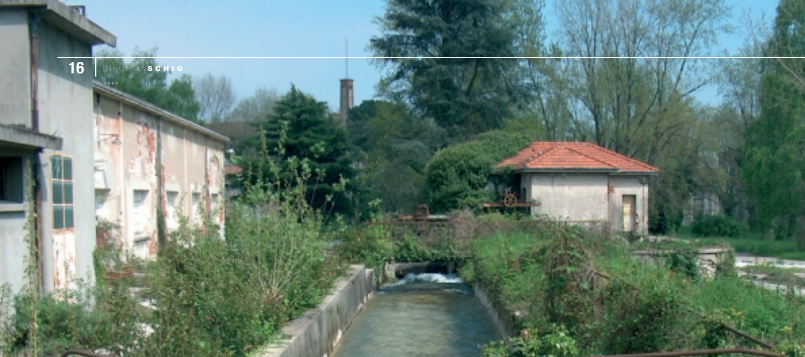
AREA LANEROSSE: LA CENTRALE UMBERTO I PRESSO LA ROGGIA MAESTRA
