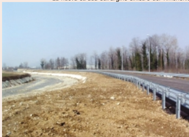
La nuova strada sull'argine sinistro del Timonchio
