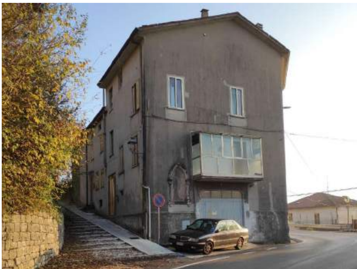
Ingresso inferiore alle Scalette e accordo alla strada provinciale
