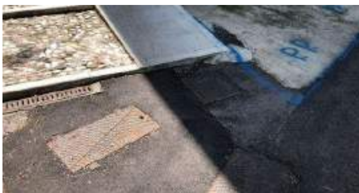
Le foto rilevano lo stato di raccordo tra la parte del percorso ripristinato nel 2012 e la strada provinciale.
