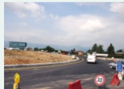
Lavori in corso nella Statale 349.
