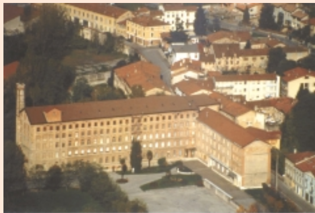
Vista dall'alto della Fabbrica Alta (foto P. Tomiello).
