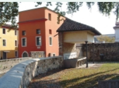
Lavatoio che si trova all'incrocio tra Via Manin e Via Pilastrò.
